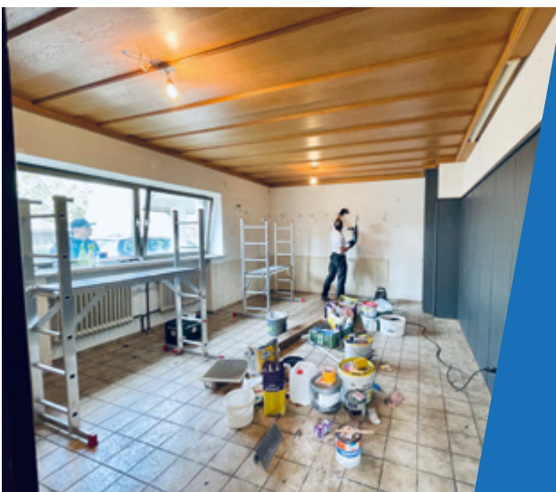
Umbau vom Nebenstüberl...
